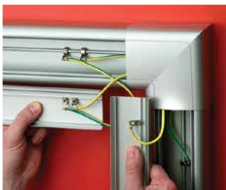
Количество монтируемых проводов заземления в плоском угле
