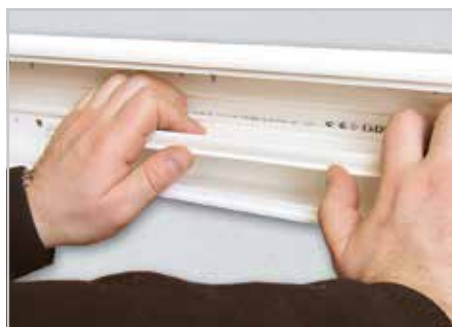
Разделитель защелкиванием устанавливается на направляющие дна короба
