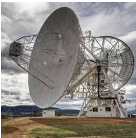
Системы управления и телекоммуникации
