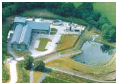
Пример труднодоступной насосной станции
